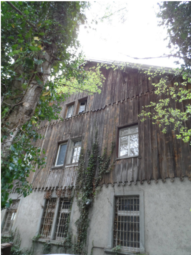
Abbildung 2: Westseite des Hauptgebäudes mit vielen Spaltenstrukturen
